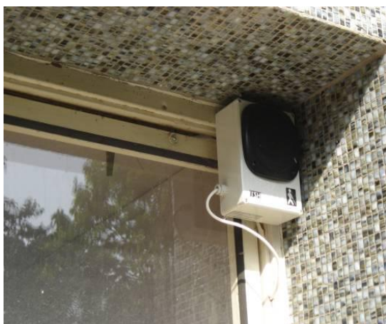
foto: Ozvučení budovy akustickým orientačním majáčkem
