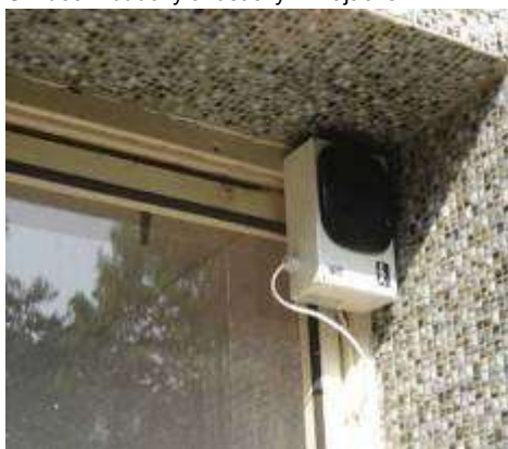
Ozvučení budovy akustickým majáčkem
